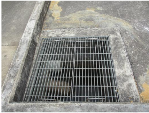
รูปที่ 3.2-18 พื้นที่คอนกรีตที่ลาดเอียง เข้าหาบ่อดักน้ำ (Catch Basin)
