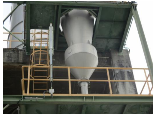
รูปที่ 3.2-6 เครื่องดักฝุ่นแบบไซโคลน (Cyclone)
