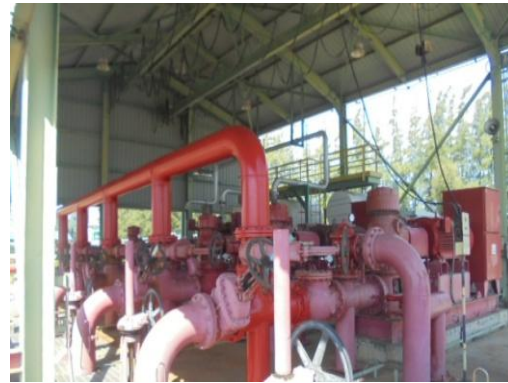
รูปที่ 3.2-52 บ่อน้ำสำรอง และปั้มน้ำดับเพลิง
