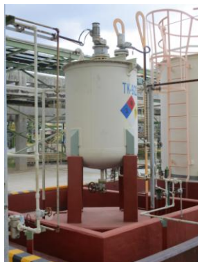
รูปที่ 3.2-44 คั่นคอนกรีต บริเวณถังเก็บก๊าซโพรพิลีนไฮดรอกไซด์ (TK-922)
