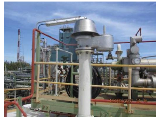
รูปที่ 3.2-4 ระบบท่อรวบรวม Vent Gas
