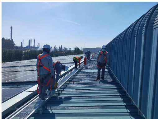
รูปที่ 3.1-1 กิจกรรมการติดตั้งระบบผลิตไฟฟ้าด้วยเซลล์แสงอาทิตย์บนหลังคาอาคาร
