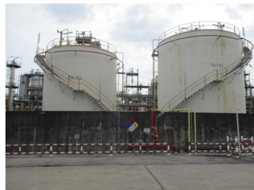
รูปที่ 3.2-43 คันคอนกรีต บริเวณถังเก็บกากเฮกเซน (TK-702, TK-703)
