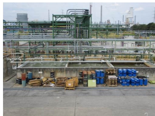
รูปที่ 3.2-13 ถังตรวจสอบคุณภาพน้ำเสีย
