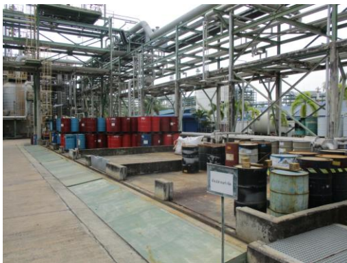
รูปที่ 3.2-32 Concrete Curb รอบพื้นที่เก็บพักของเสีย
