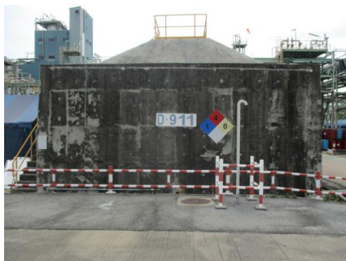
รูปที่ 3.2-42 คันคอนกรีต บริเวณถังเก็บกากบิวทีน-1 (D-911)
