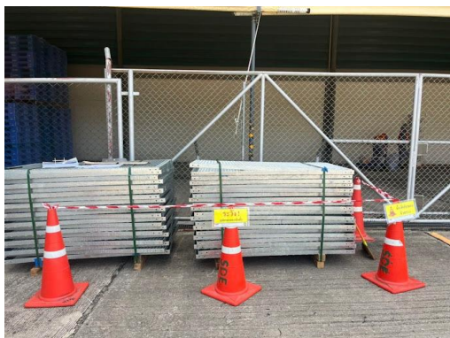
รูปที่ 3.1-3 พื้นที่จัดเก็บวัสดุอุปกรณ์ก่อสร้างมีวัสดุปิดคลุม
