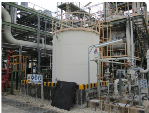
รูปที่ 3.2-40 คันคอนกรีต บริเวณถังเก็บสารเคมี
