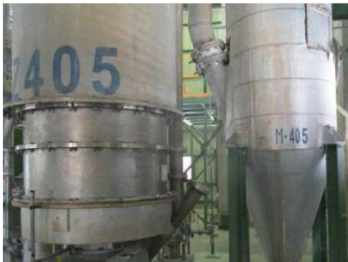
รูปที่ 3.2-5 ระบบดักฝุ่นแบบถุงกรอง (Bag Filter) (M-405)
