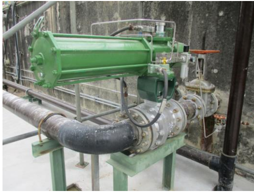
รูปที่ 3.2-7 Control Valve
